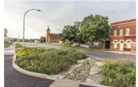
Eine Blähtonschicht reproduziert die Mechanismen, die in natürlichen Umgebungen und unter durchlässigen Oberflächen und Senken vorkommen. Fibo ExClay Blähton wird als hochkapazitives Rückhaltedmedium eingesetzt.
