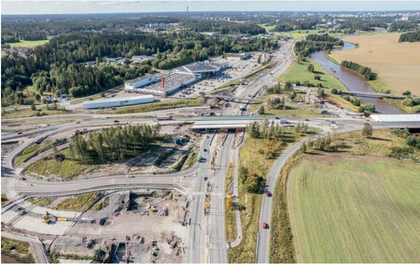
Die Bauarbeiten für das 35 Millionen Euro teure Projekt begannen im August 2020.
