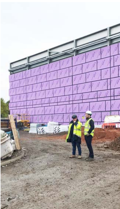
Durch die Verwendung von Leca konnte der Arbeitsaufwand im Vergleich zu einer Schüttung des Typs GSB um 50 % verringert werden.
