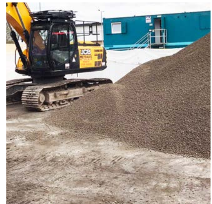
Der Einsatz von Leca sparte vermutlich über 10 Tage an Zeit und bot außerdem den Vorteil, dass sich dadurch die thermischen Werte des Schwimmbeckens verbesserten
