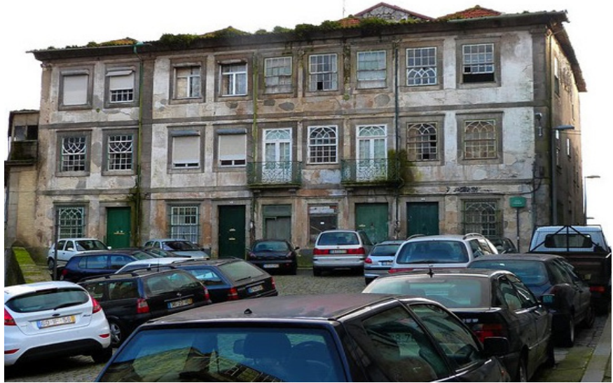
Die Sanierungsarbeiten begannen im Jahr 2019, wobei die ursprünglichen Gebäudemerkmale erhalten blieben. (Photo: @Teodósio Dias 2013)
