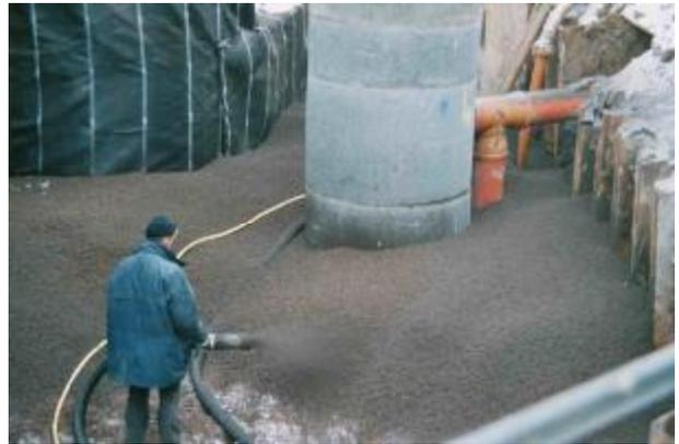
Bild 12: Einblastechnik LECA®GEO
