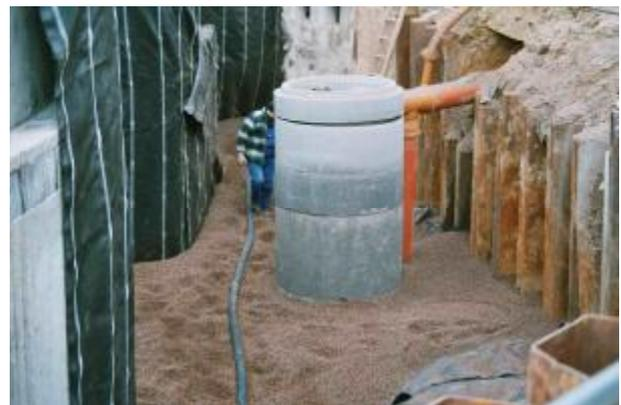
Bild 4: Einbau LECA®GEO Baugrubenverfüllung
