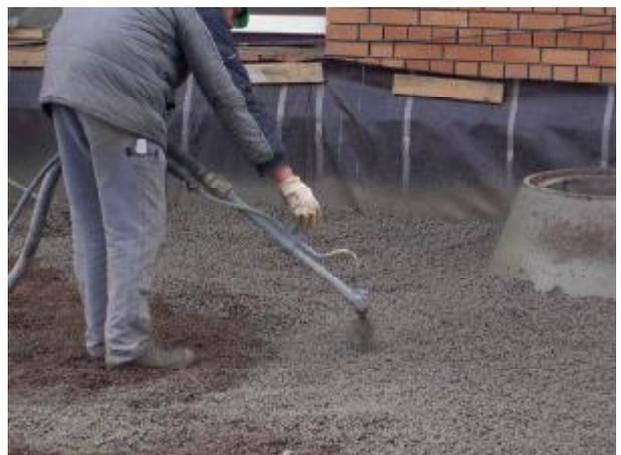
Bild 9: Oberflächensicherung mit dem LECA®GEO-Binder
