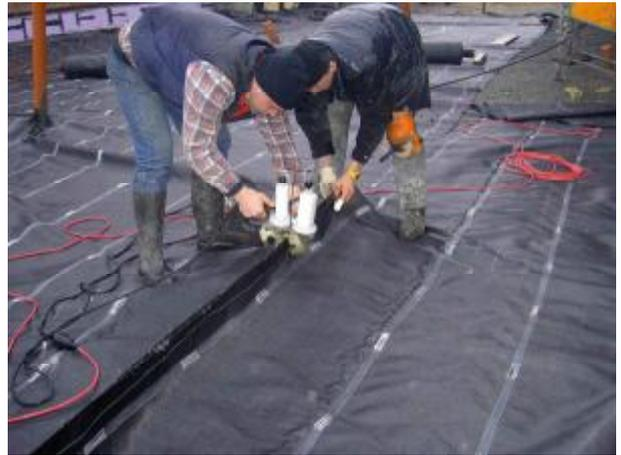
Bild 8: Geotextil wird vernäht
