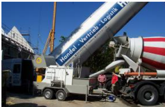
Bild 3: LECA®GEO GS Einbautechnik
