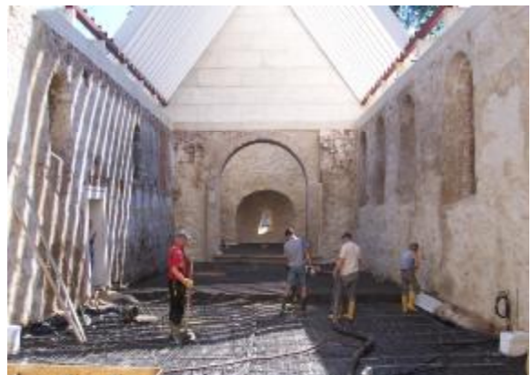
Bild 5: LECA®GEO GS Einbau
