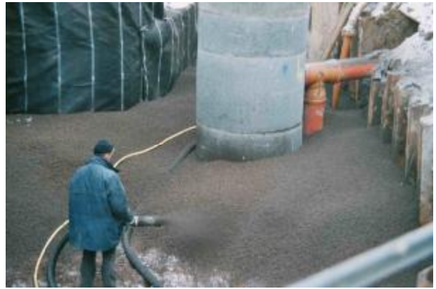
Bild 12: Einblastechnik LECA®GEO
