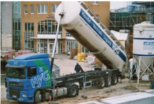
Bild 11: Anlieferung LECA®GEO der Körnung 8-16 mm
