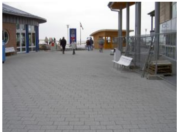
Bild 17: Neue Außenanlage ‚Biomaris‘
