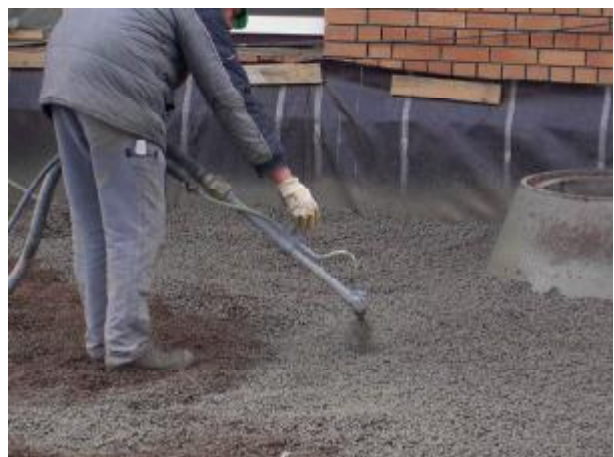
Bild 9: Oberflächensicherung mit dem LECA®GEO-Binder
