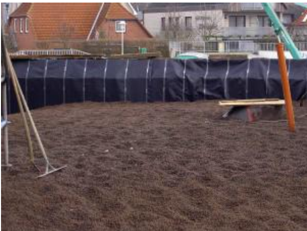
Bild 9: Oberflächensicherung mit dem LECA®GEO-Binder
