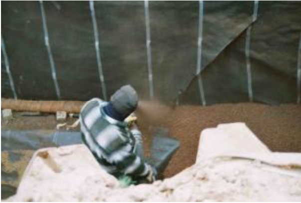
Bild 10: Dränage am Tiefpunkt der Schüttung
