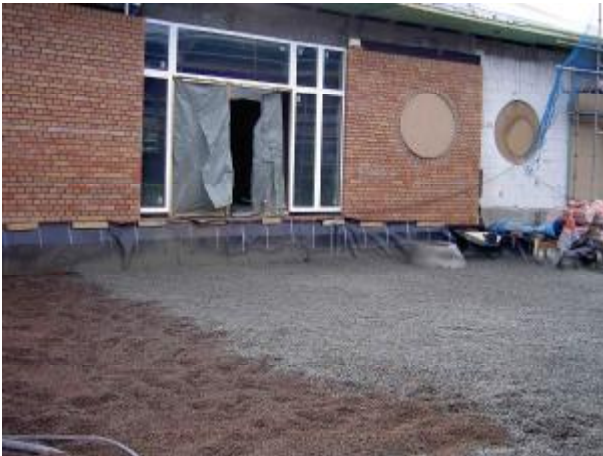
Bild 14: LECA® GEO-Binder aufgetragen
