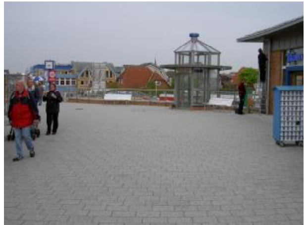
Bild 16: Vorplatz nach Fertigstellung
