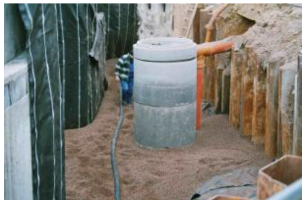
Bild 4: Einbau LECA®GEO Baugrubenverfüllung
