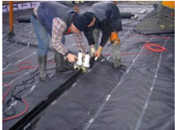
Bild 8: Geotextil wird vernäht
