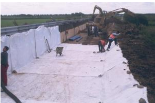
Bild 7: Geotextil zur Trennung der Schüttung
