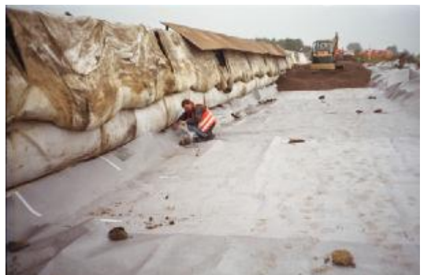
Bild 9: Dammkern aus Blähton
