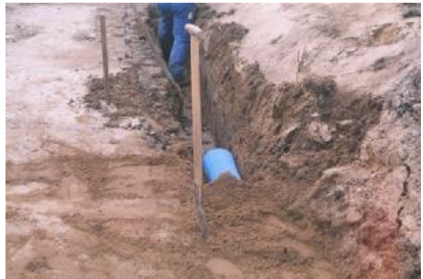
Bild 8: Drainage zur Entwässerung des Dammes
