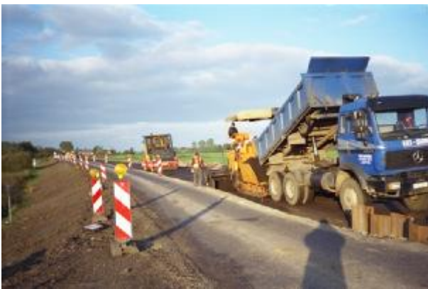
Bild 11: Unterbauverbesserung
