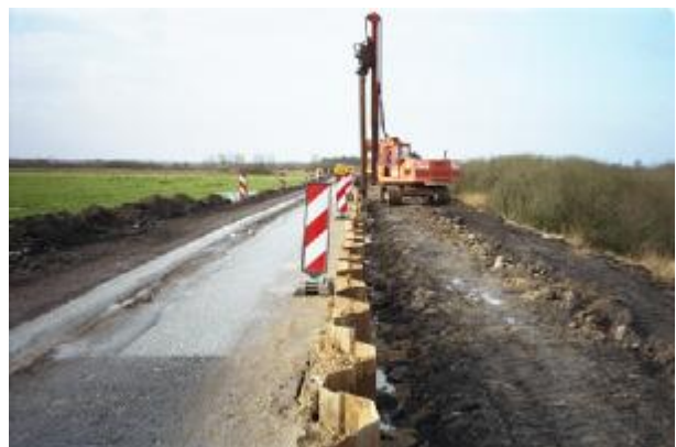
Bild 14: Spundwandverbau - Straenmitte
