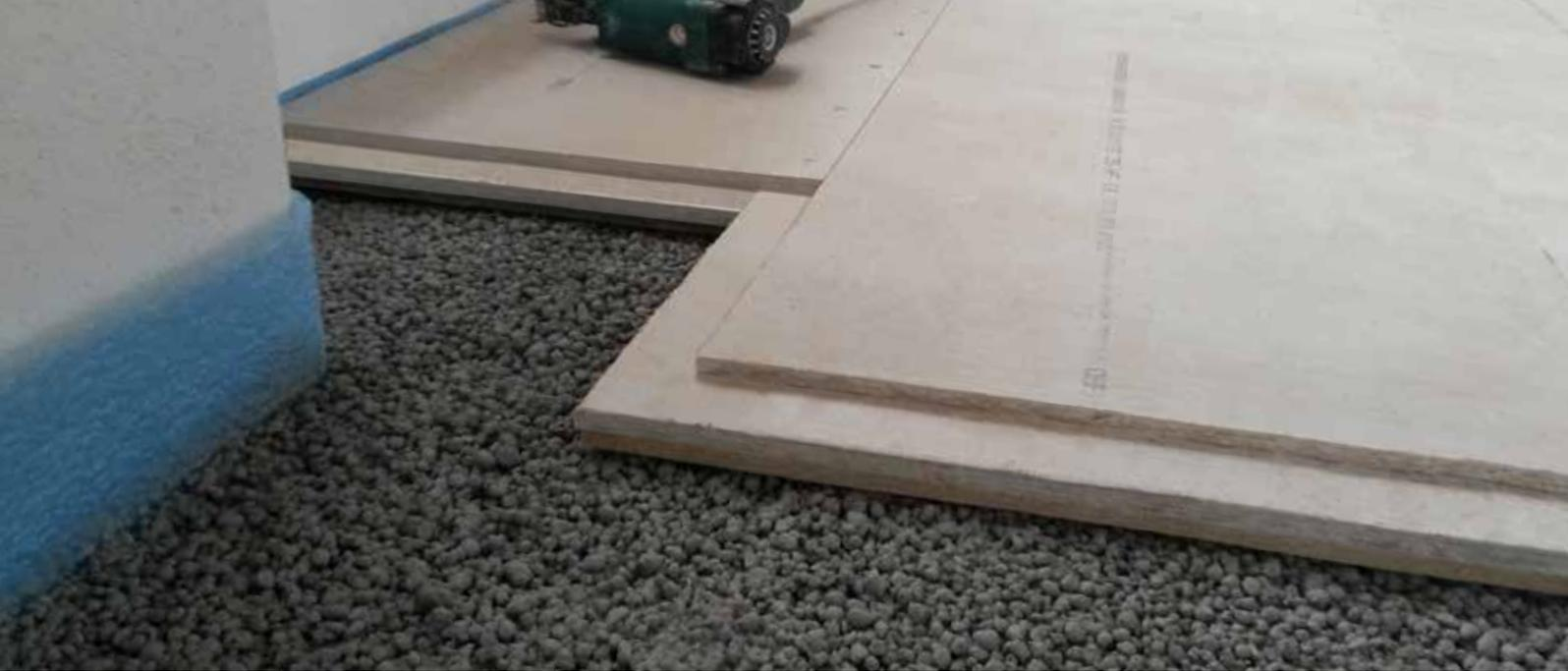
Neben den losen Schüttungen haben wir auch unsere gebundene Schüttung **FIBO FLOORMIX** geprüft; diese erlaubt eine geringere Dicke der Gesamtkonstruktion.
